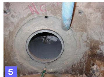
図5. 急結モルタル打設状況
