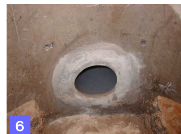
図6. モルタル仕上げ
