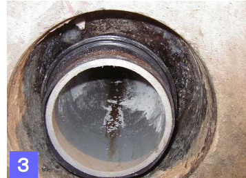
図3. エクセルジョイント取付完了
