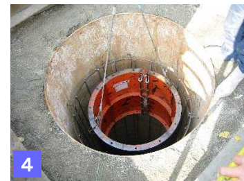
図4. 内壁型枠設置状況
