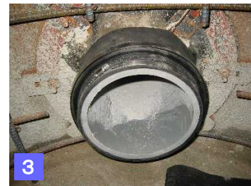
図3. エクセルジョイント取付完了
