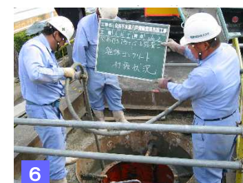
図6. モルタル打設状況(2)
