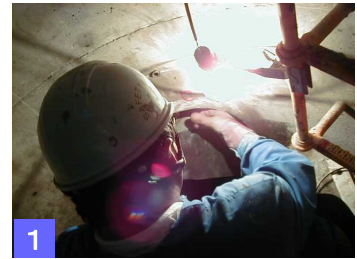
図1. バックアップ材B取付状況
