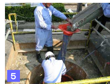
図5. モルタル打設状況(1)
