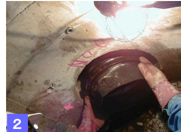
図2. エクセルジョイント本体取付状況
