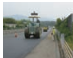
NEXCO西日本 山陽道工事(東広島)
