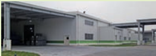
完成した第2工場
