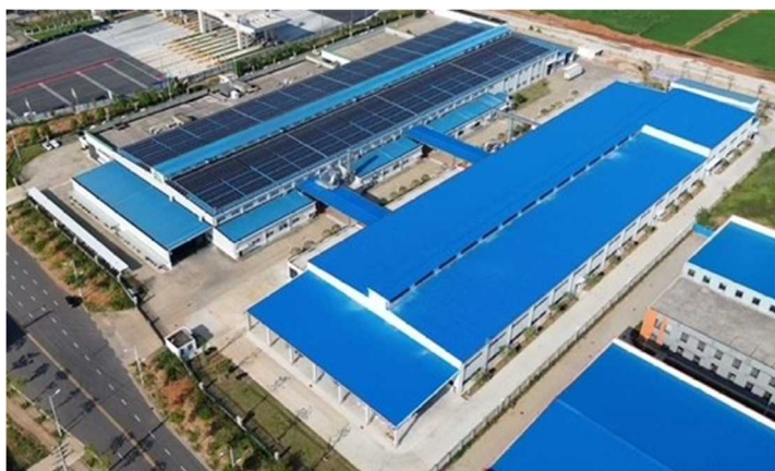
写真左（太陽光パネル有）：湖北西川密封系統有限公司 第1工場 写真右：湖北西川密封系統有限公司 第2工場
